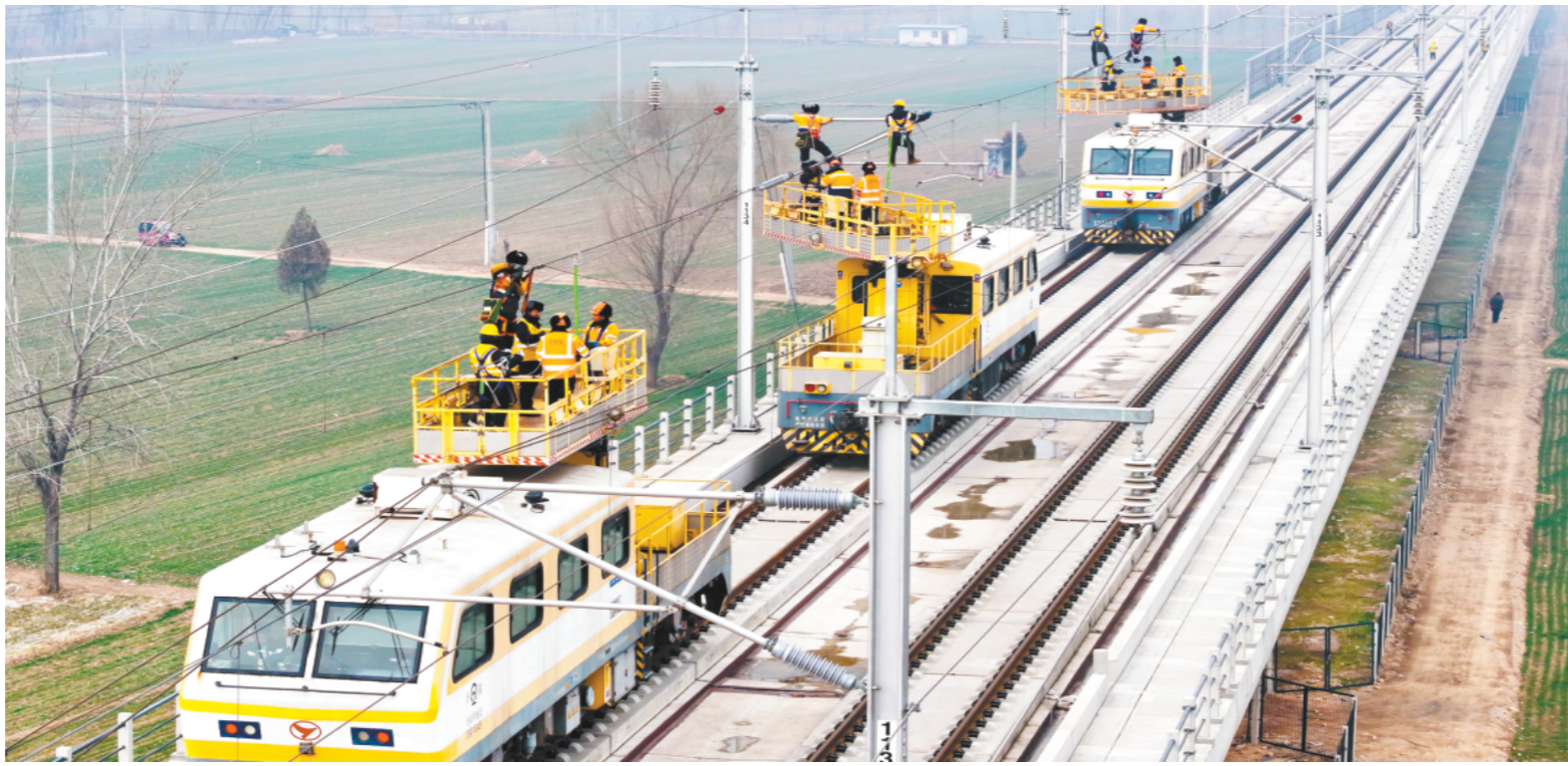
在雄商高铁山东菏泽段，中国铁路济南局集团有限公司济南供电段的工作人员对接网设备进行检查验收(2026年2月1日摄，无人机照片)。
