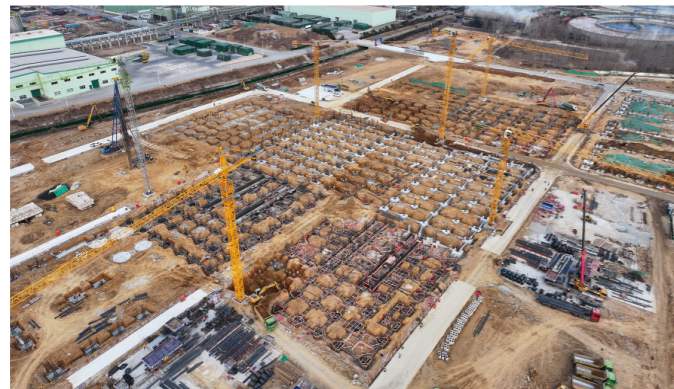
生活纸二期建设现场。
