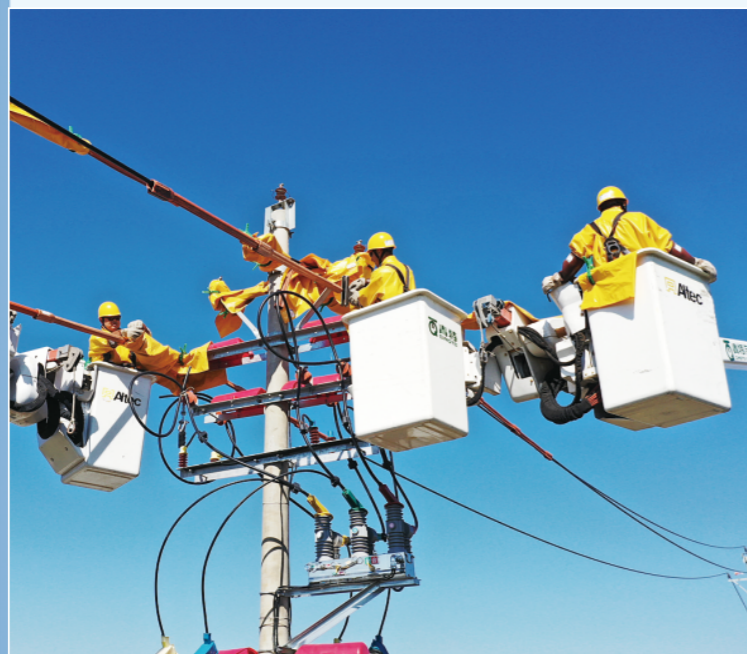
国网日照供电公司工作人员在10千伏于青南Ⅰ线开展带负荷直线杆改耐张杆带电作业。
