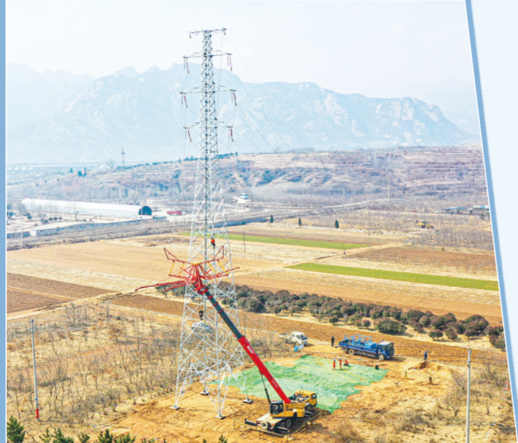
国网日照供电公司工作人员使用伞形跨越架开展110千伏莲印京线组塔放线工作。
